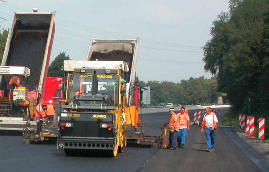
Linkes Bild: A 3 bei Köln – Demonstration der Drainagefähigkeit bei offenporigem Asphalt
