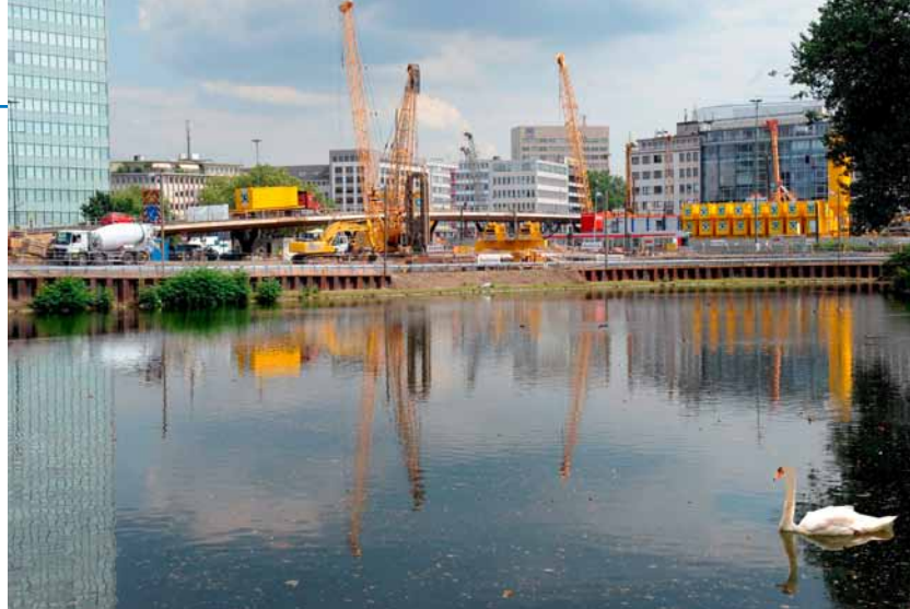
Brückner Grundbau als Generalunternehmer einer innenstädtischen Baugrube in Düsseldorf; Gewerke: Schlitzwände, Verankerungen, Primärstützen und Erdarbeiten.
