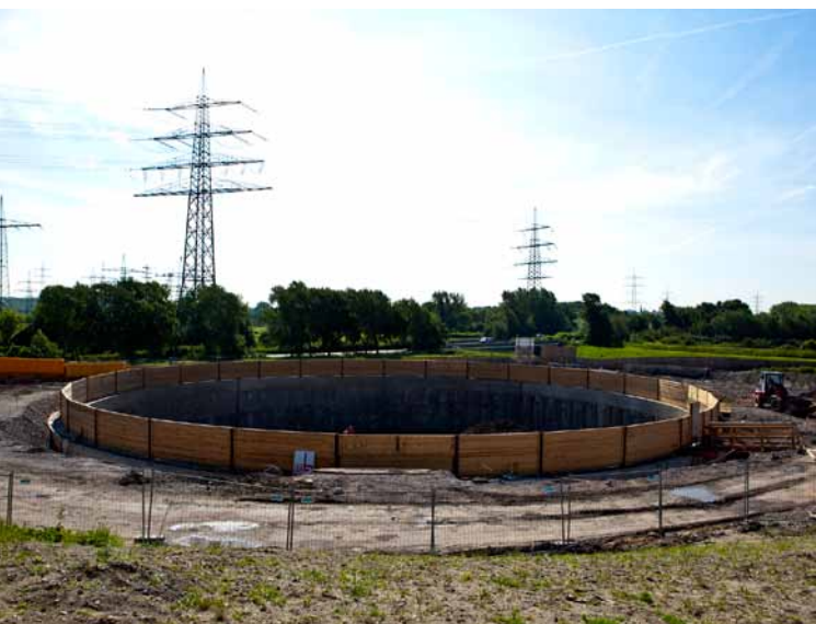
Die kreisrunden Baugruben der Pumpwerke sind 50 Meter im Durchmesser und 40 Meter tief.
