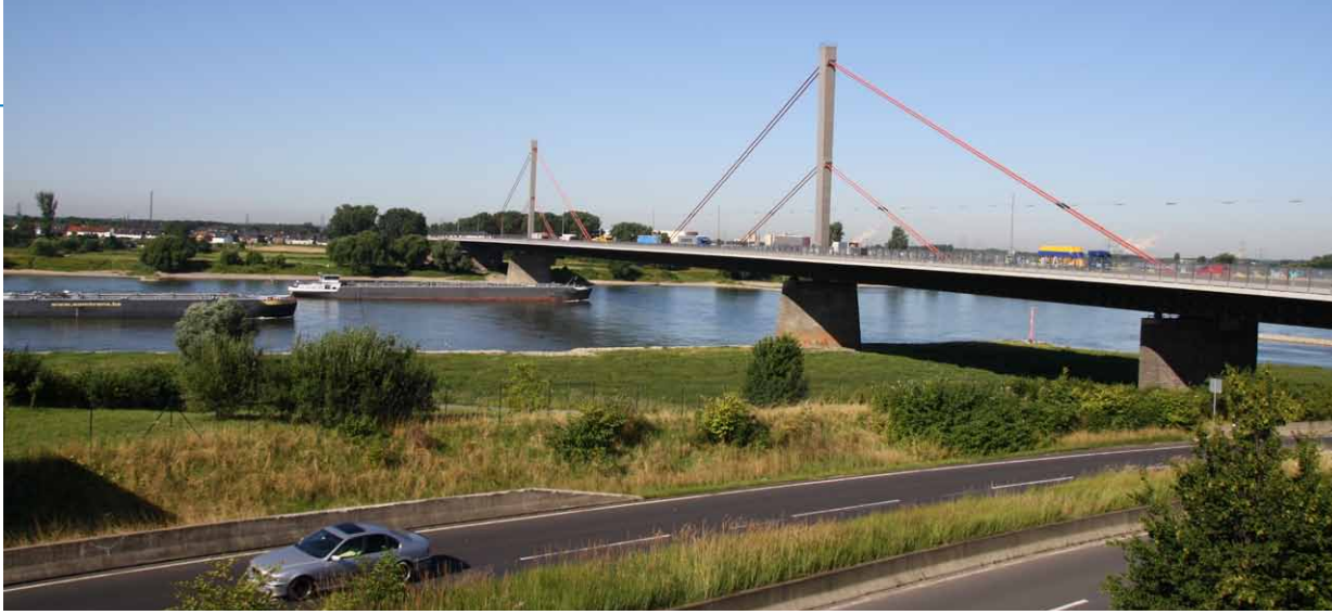
Die Rheinbrücke der A1 bei Leverkusen
