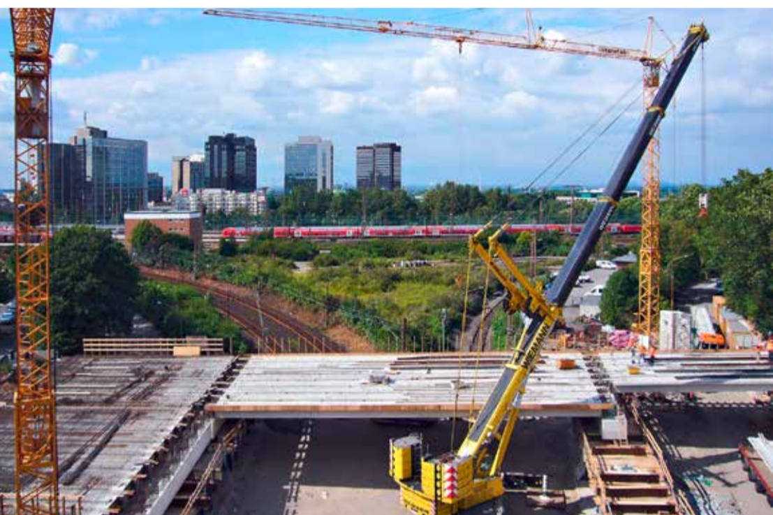
Die Großbaustelle A40 ist ein erfolgreiches Beispiel für notwendige Infrastrukturmaßnahmen.
