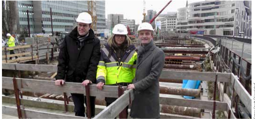
Oben: Blick in die Baugrube des Nord-Süd-Tunnels, der den früheren Tausendfüßler ersetzt.
