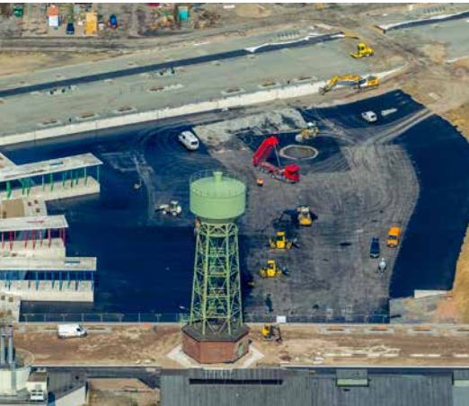
Umbau der ehemaligen Zeche Lohberg in Dinslaken zum Kreativquartier
