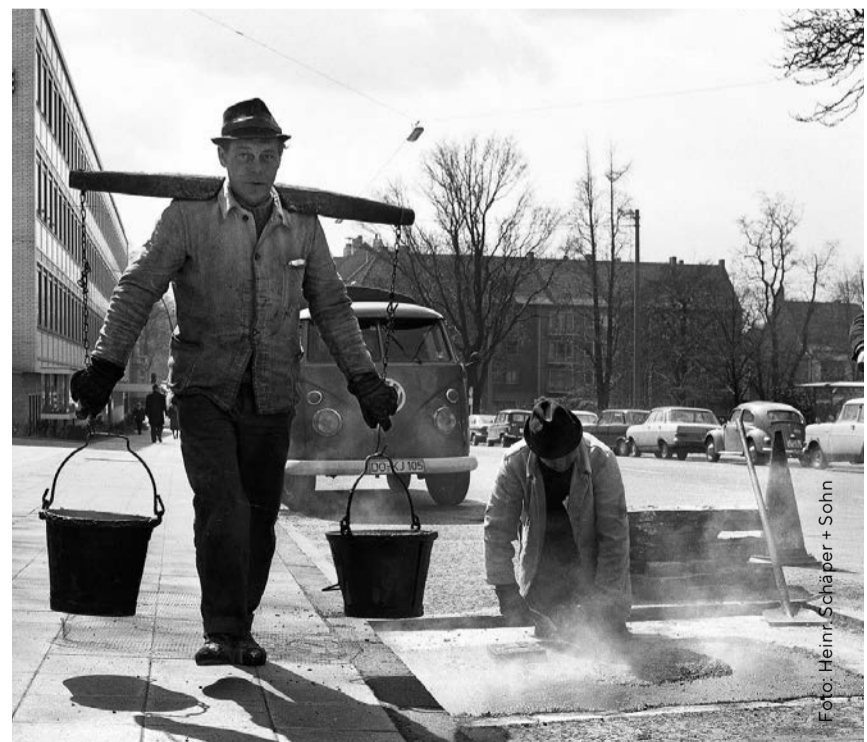
Asphalteinbau in den 1950er-Jahren.
