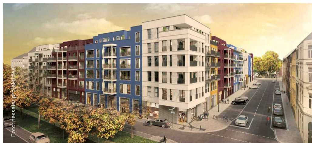
Der Gebäudekomplex „Viktoria“ wurde mit der BIM-Methode geplant. Die Bauabwicklung erfolgt nach dem LEAN Construction Management-Prinzip.
