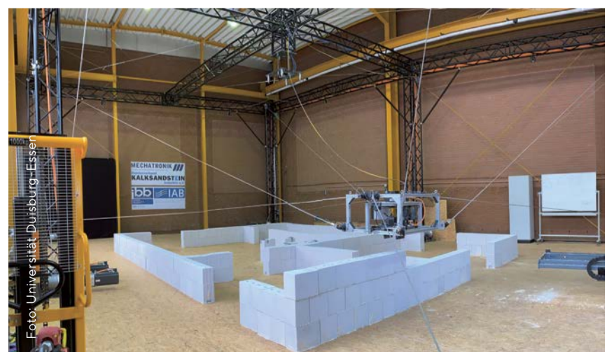
Seilroboter erleichtern die Arbeit und können beim Fachkräftebedarf helfen, ohne dass sie den Menschen auf dem Bau überflüssig machen.
