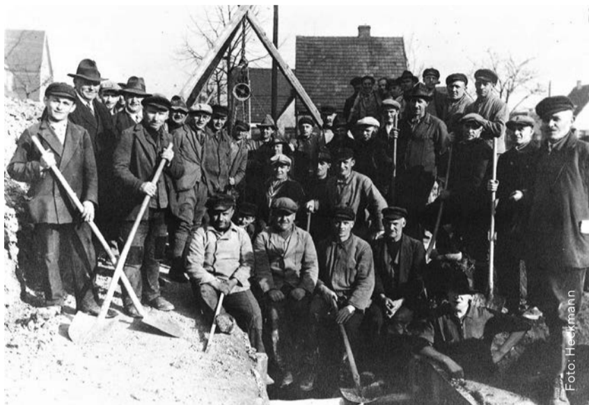
Heckmann-Mitarbeiter bei Kanalbauarbeiten im Jahr 1932.
