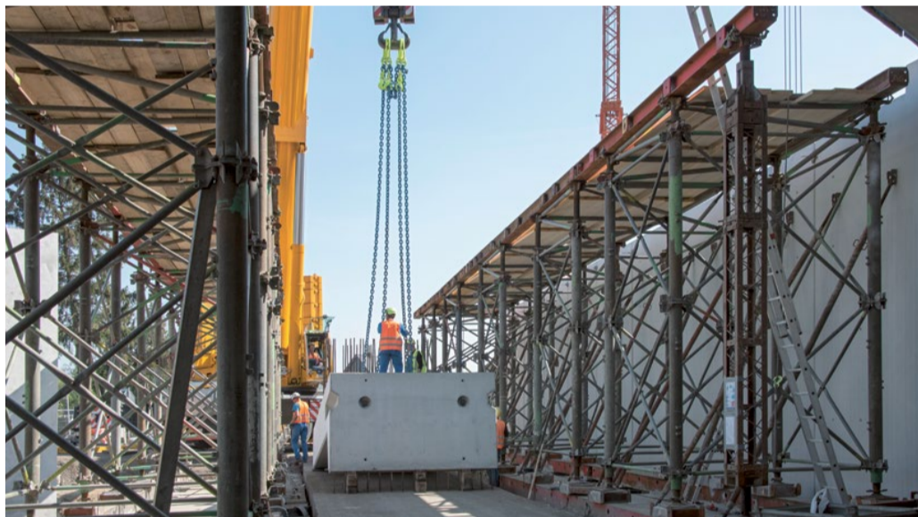
Die Fertigteile stehen zum Einbau auf dem Afferder Weg bereit.
