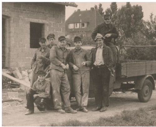
Eine Maurerkolonie in den 1950er Jahren vor ihrem Bauwerk.
