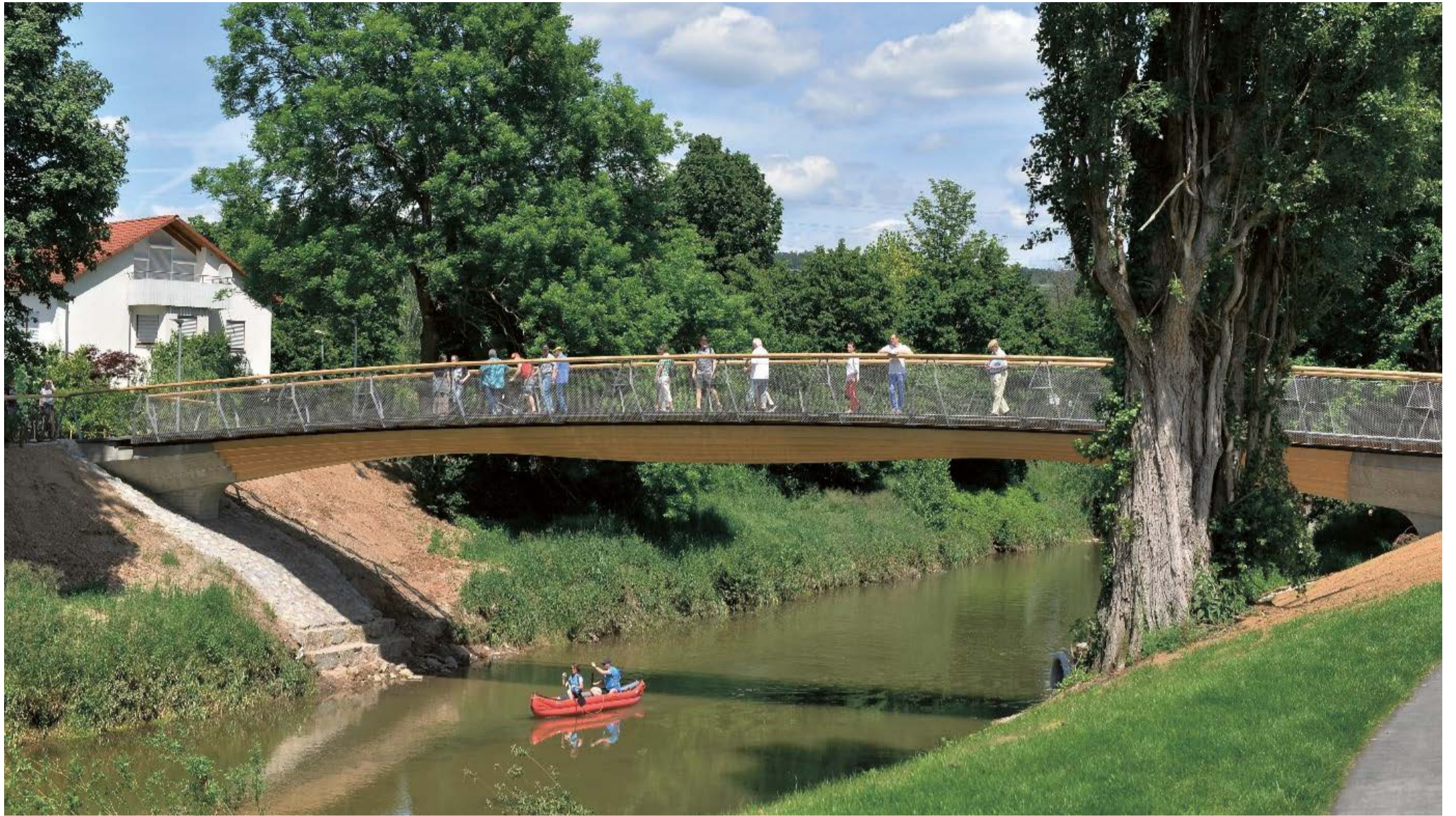
Für die Fußgänger- und Radwegebrücke „Birkelspitze“ in Weinstadt bei Stuttgart wurde die HERING Bau GmbH aus Burbach mit dem Deutschen Brückenbaupreis 2020 ausgezeichnet.
