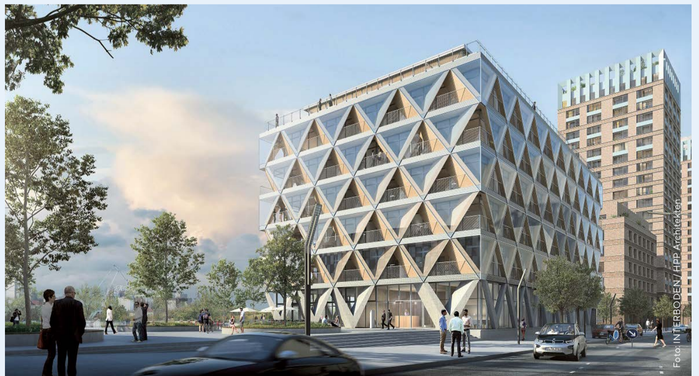
The Cradle: Im Düsseldorfer Medienhafen entsteht das erste Holzhybrid-Bürogebäude, eine der nachhaltigsten Immobilien Deutschlands. Das bereits mehrfach ausgezeichnete Projekt wird nach dem Cradle to Cradle® - Prinzip gebaut. Ziel ist es, den CO 2 -Ausstoß auf ein Minimum zu reduzieren und den Großteil der Bestandteile aus recyclebaren Materialien herzustellen, die anschließend wieder in den Materialkreislauf zurückgegeben werden können.
