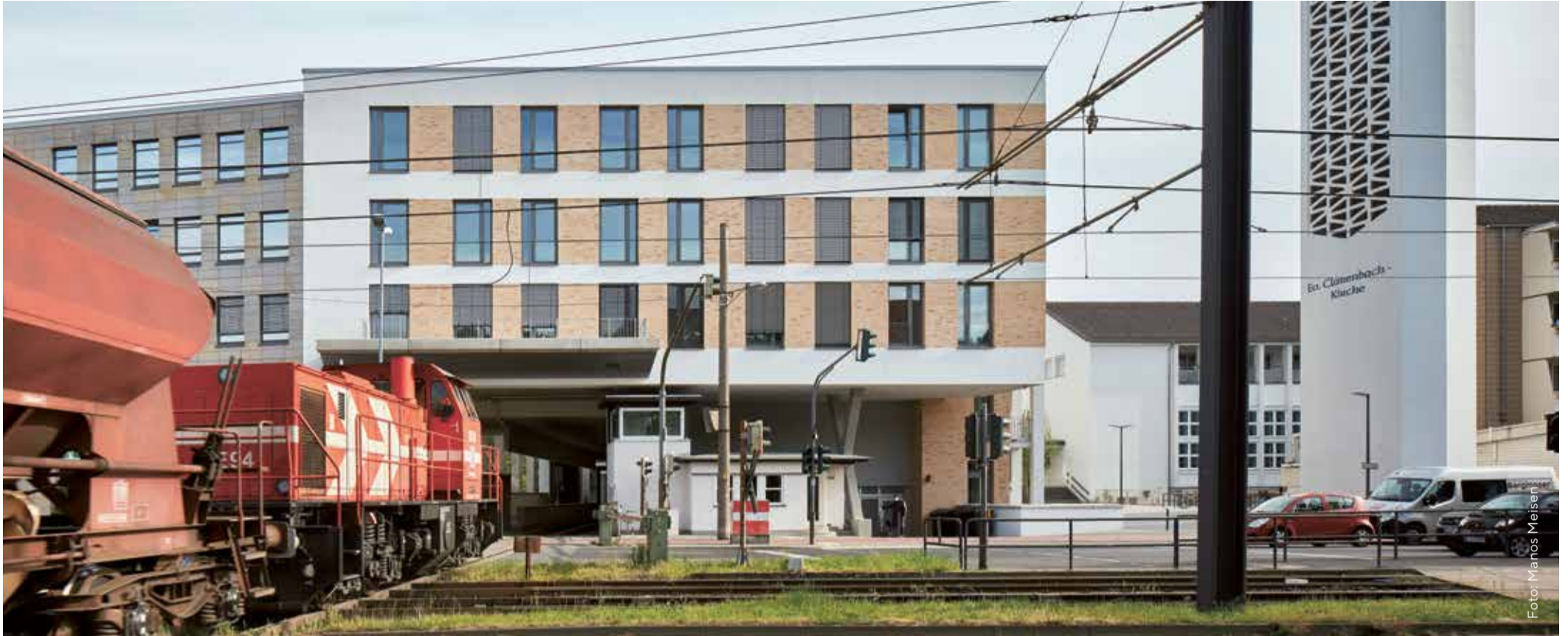
Das neue Quartier Clarenbachplatz mit 67 Wohneinheiten und 540 Quadratmetern Gewerbefläche. Die Überbauung von aktiven Bahngleisen mit Wohnungen ist europaweit einmalig.
