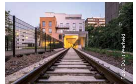
Eine erschütterungsarme feste Fahrbahn schützt die Bewohner vor Vibrationen.
