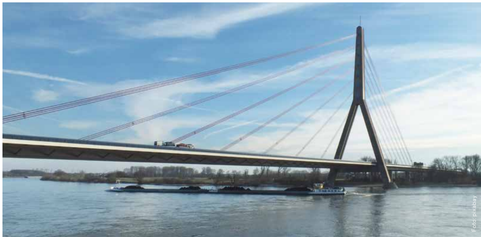
Ein Beispiel von vielen: Die A46-Rheinbrücke Flehe in Düsseldorf ist zwischen 1976 und 1979 entstanden. Sie wurde für die damals höchste Brückenklasse ("BK60") entworfen. Die Baukosten betragen 94 Millionen Mark. Die Schrägseilbrücke muss einem Gutachten zufolge neu gebaut werden. Die Gesamtkosten für das Bauprojekt sollen sich auf etwa 300 Millionen Euro belaufen. Die Bauarbeiten sollen laut der Autobahn GmbH 2030 beginnen; 2035 soll die Brücke voraussichtlich fertig sein.
