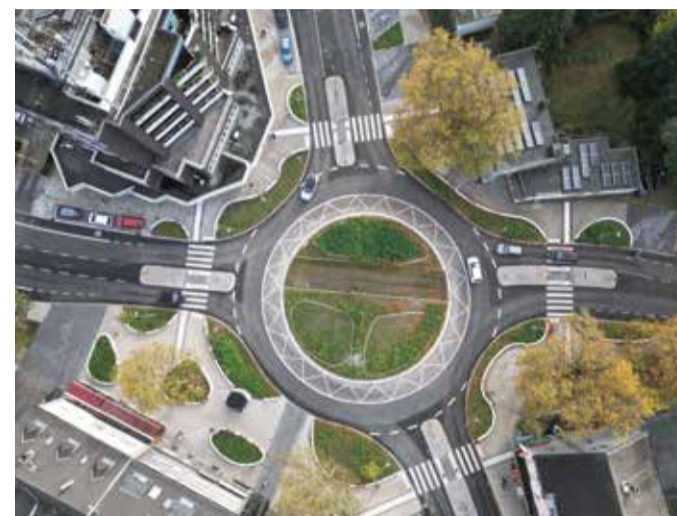
// Bau eines Kreisverkehrs, Bochum
