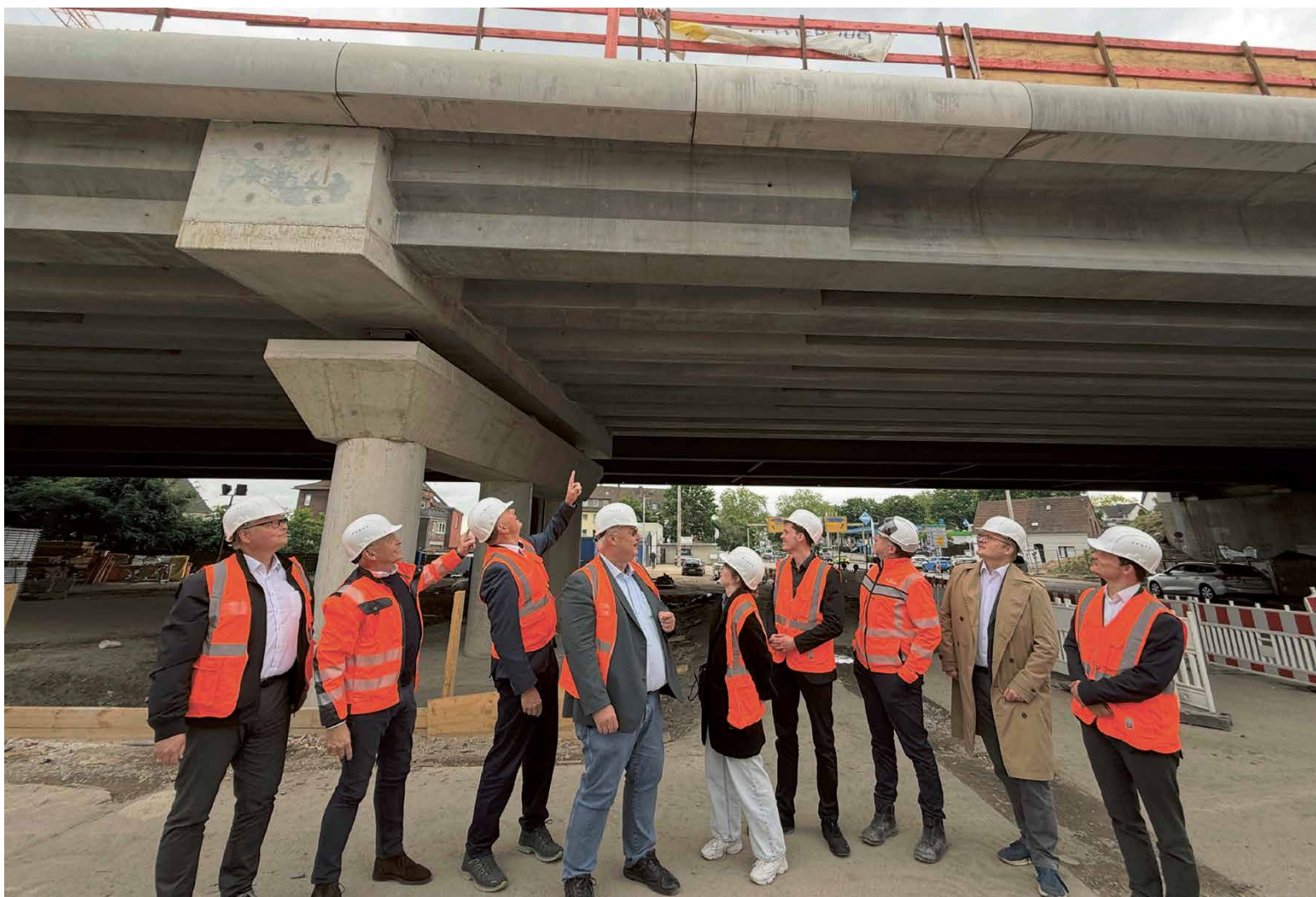
// Vom Landtag auf die Brücke: Mitglieder des Verkehrsausschusses des Landtags NRW sowie Mitarbeitende aus Fraktionen und MdL-Büros informierten sich in Oberhausen-Sterkrade über den Ersatzneubau zweier Autobahnbrücken im Zuge der A 516.
