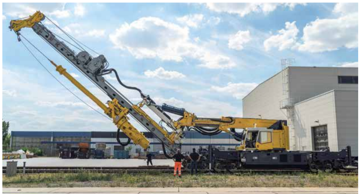
// Der Gleisgründungszug ermöglicht mehr Effizienz und eine besonders präzise Gründung im Gleisbau.
