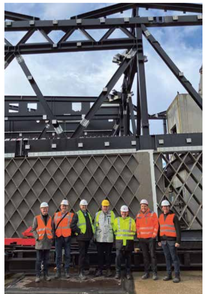
// Die Mitglieder des Verbandsbezirks erhalten spannende Einblicke in die Fortschritte auf der Baustelle.
