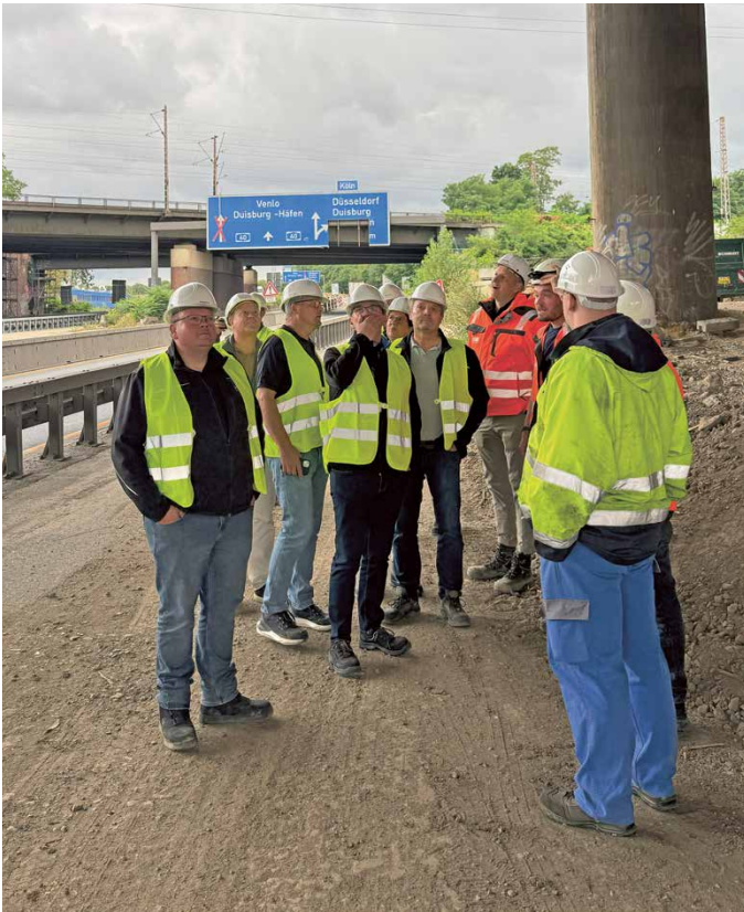
// Spannende Einblicke in die Baufortschritte am Kreuz Kaiserberg
