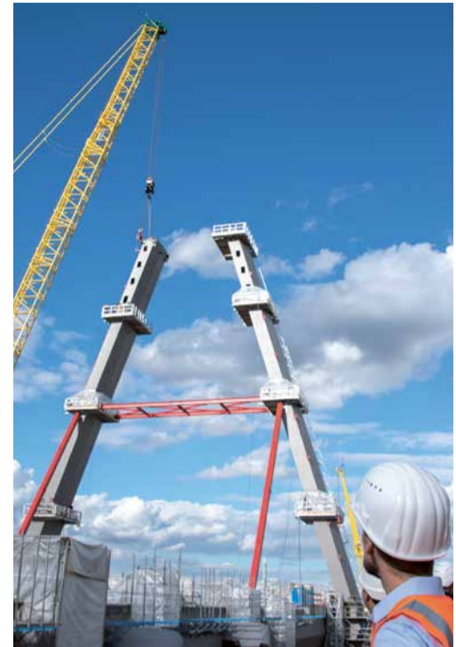
// Der 1.000 Tonnen schwere Pylon der neuen Leverkusener Brücke wird montiert.
