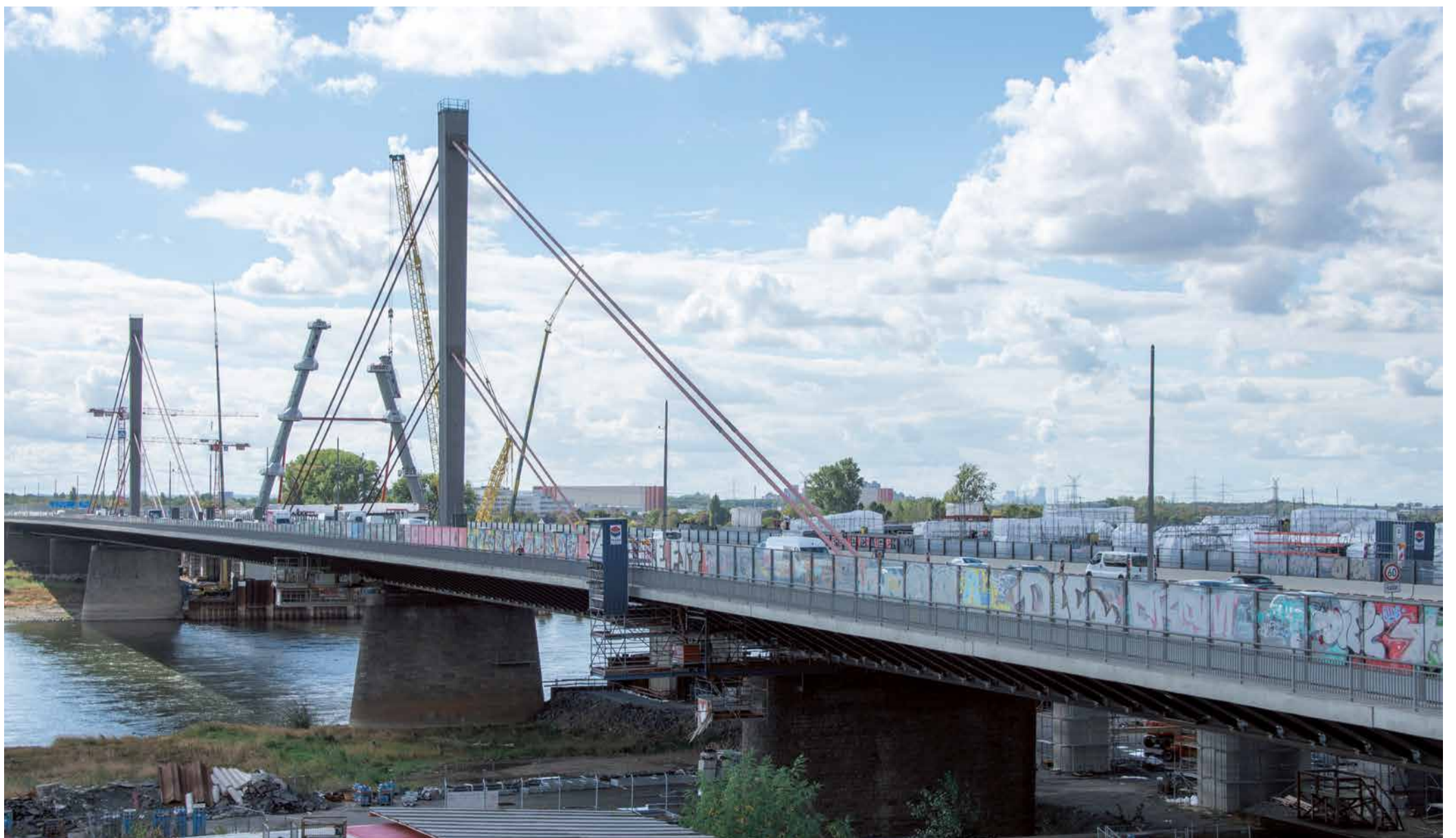
// Mit zwei Fahrspuren plus Standstreifen war die Leverkusener Rheinbrücke in den 1960er Jahren ein zukunftsweisendes Stück Infrastruktur. Einst konzipiert für 40.000 Kraftfahrzeuge pro Tag, fahren derzeit circa 100.000 Kraftfahrzeuge täglich über die Brücke. Vor Errichtung der Schrankenanlage für Fahrzeuge über 3,5 Tonnen Ende September 2016 waren es 120.000 Fahrzeuge täglich – darunter 14.000 Lkw.
