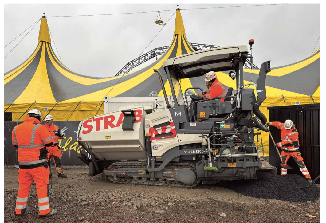
// 36 Tonnen CO 2 -reduzierter Niedrigtemperaturasphalt ohne erdölbasiertes Bitumen als Bindemittel wurden mit einem kleinen Straßenfertiger auf einer Länge von 85 Metern aufgebracht.
