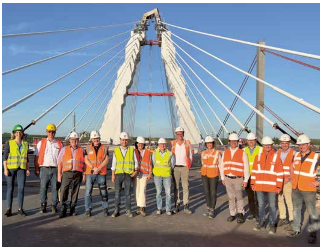
// Der Baustammtisch des Verbandsbezirks Köln trifft sich an einer außergewöhnlichen Location.
